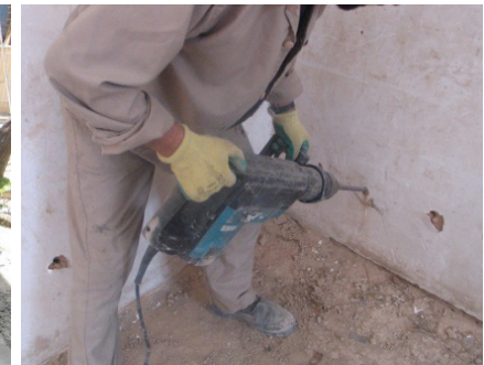
تصویر ۵. دریل زدن با استفاده از دریل چکشی (عکس از نگارنده).
