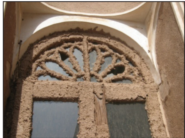
تصویر ۴. دهلیزهای موربانه روی در چوبی (عکس از نگارنده).
