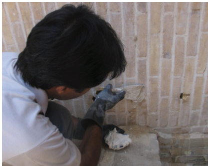
تصویر ۷. بتونه‌گیری (عکس از نگارنده).
